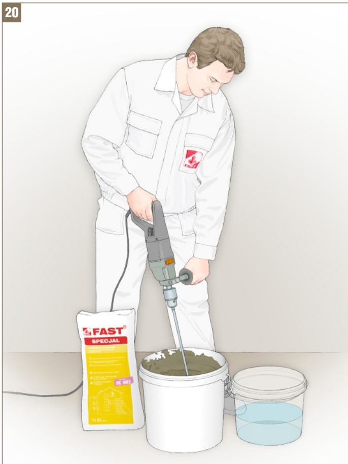
Rys. 20 - Przygotowanie zaprawy klejącej FAST SPECJAL
