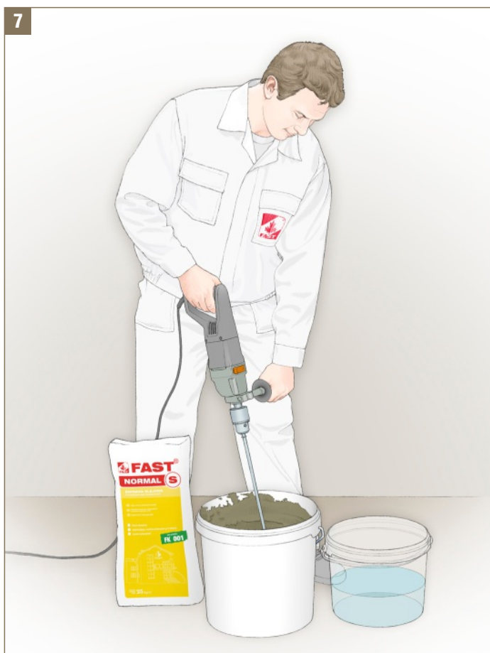
Rys. 7 - Przygotowanie zaprawy klejącej
