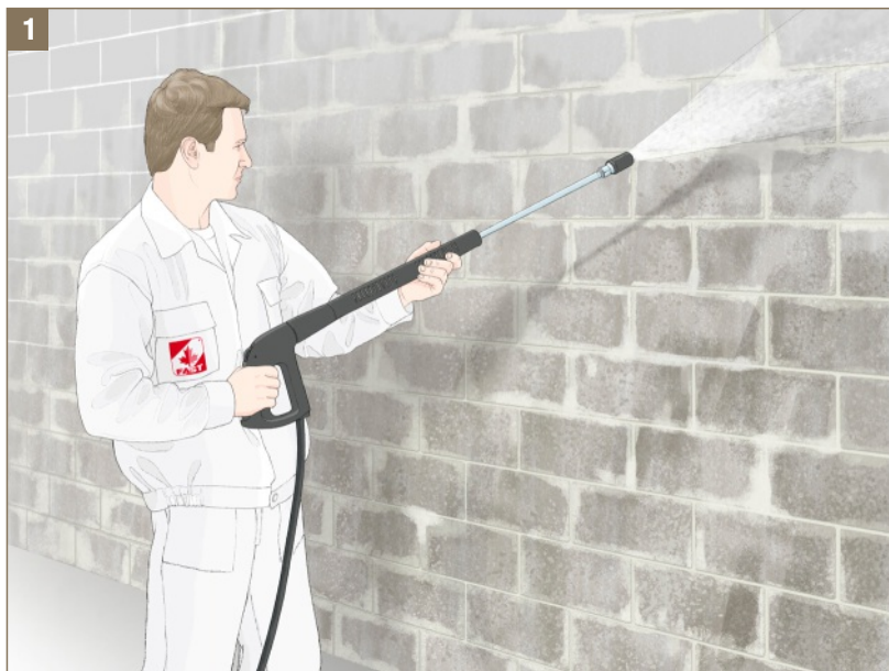
Rys. 1 - Zmycie ściany pod ciśnieniem
