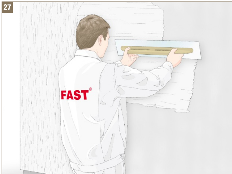
Rys. 27 - Nakładanie zaprawy tynkarskiej na zagruntowaną ścianę
