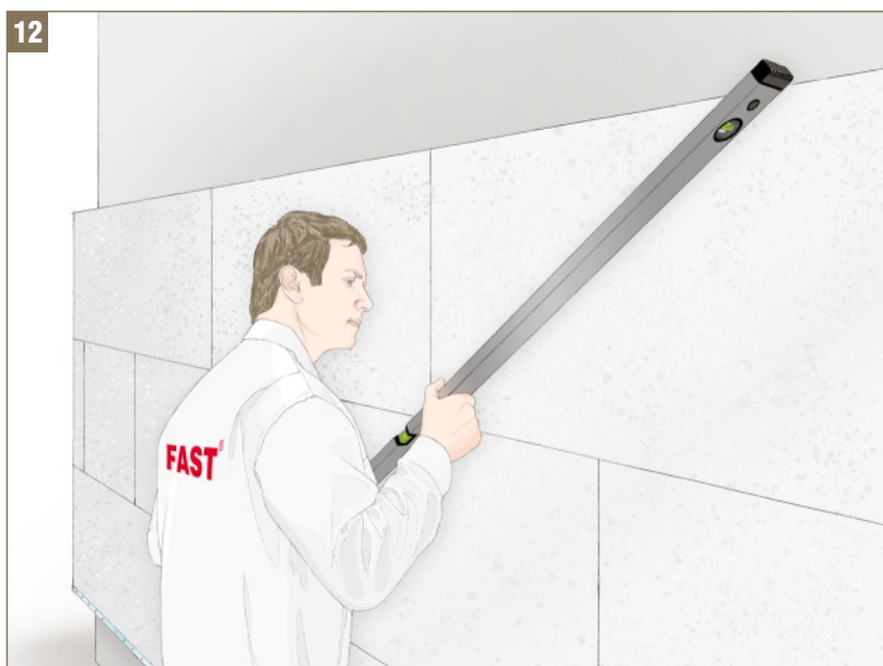
Rys. 12 - Sprawdzenie płaszczyzny płyt po przyklejeniu
