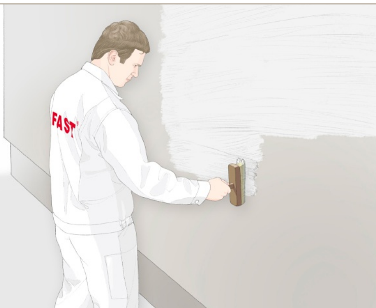
Rys. 24 - Nakładanie wyprawy gruntującej
