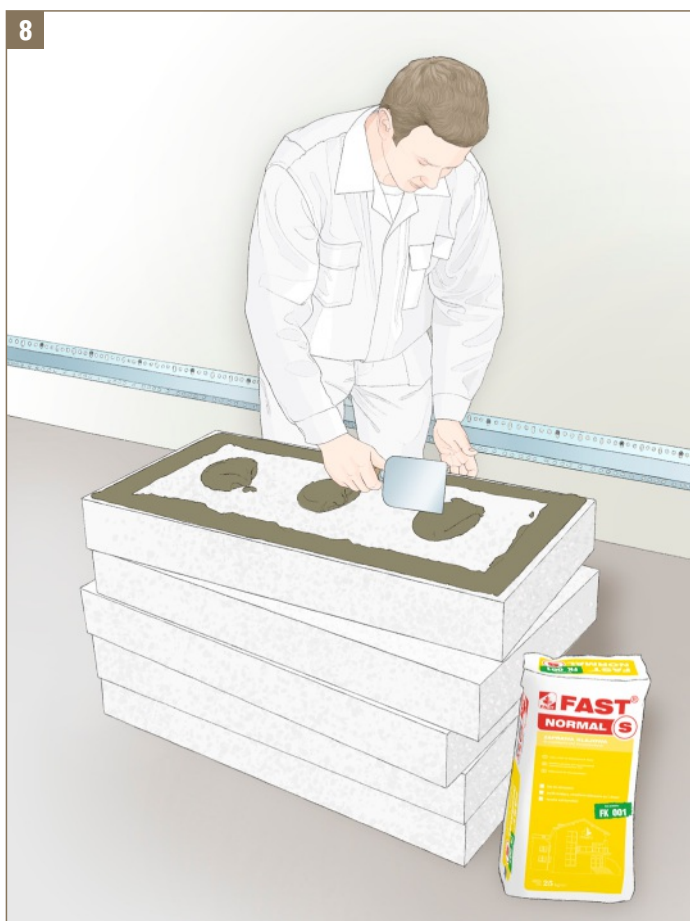
Rys. 8 - Sposób nakładania zaprawy klejącej na płyty termoizolacyjne
