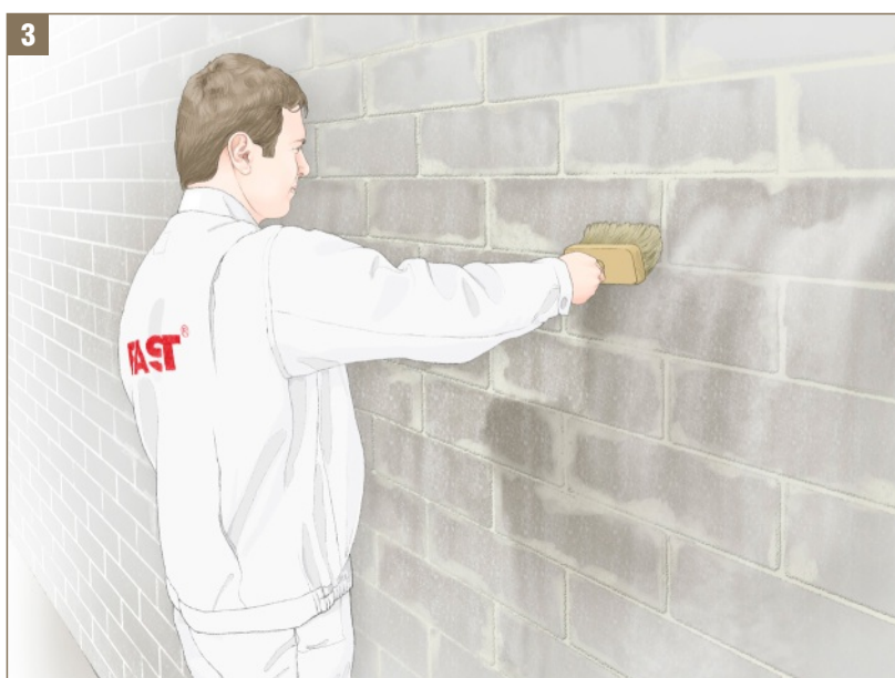
Rys. 3 - Gruntowanie chłonnych, słabych podłoży
