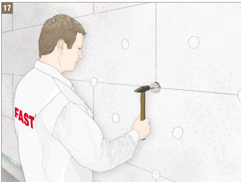
Rys. 17 - Montaż łączników mechanicznych i wbijanie trzpieni
