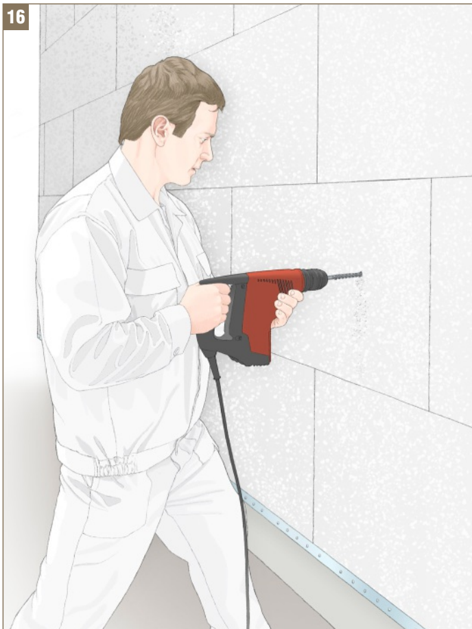
Rys. 16 - Nawiercenie otworów pod łączniki mechaniczne
