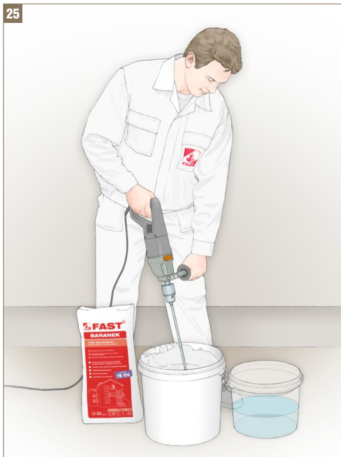
Rys. 25 - Przygotowanie mas tynkarskich przed nałożeniem (tynki polimerowo-mineralne)
