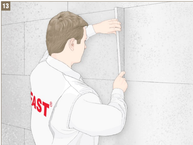
Rys. 13 - Uzupełnianie szczelin pomiędzy płytami paskami materiału termoizolacyjnego
