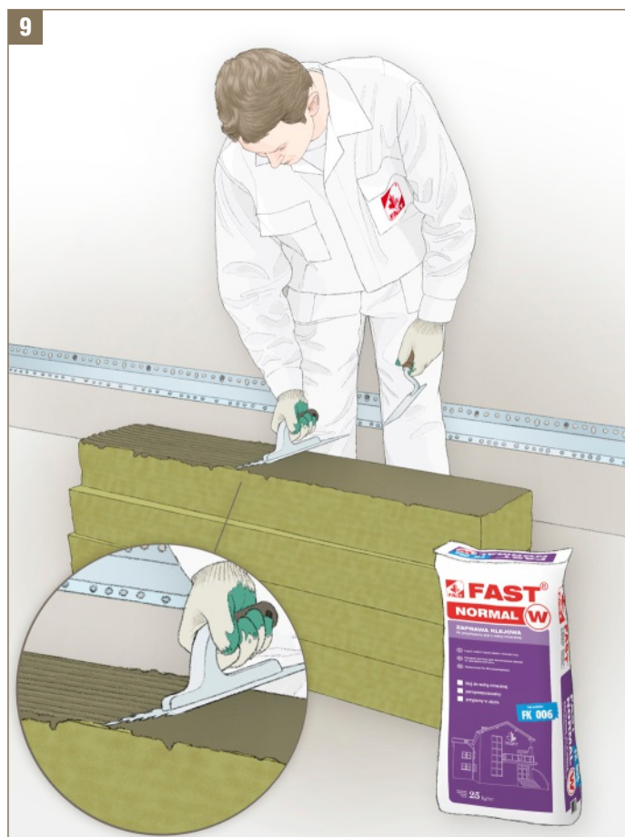
Rys. 9 - Nałożenie zaprawy klejącej na wełnę lamelową
