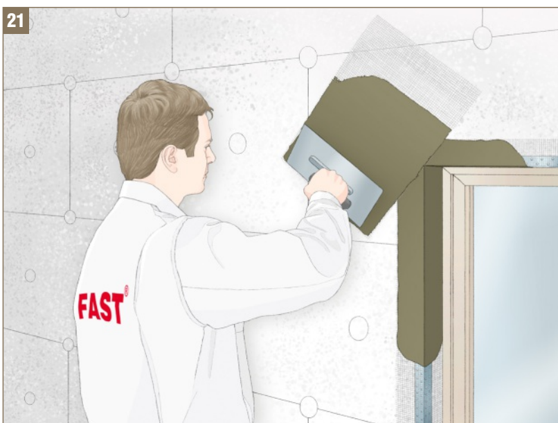
Rys. 21 - Wzmocnienie narożnika wokół otworów okiennych i drzwiowych
